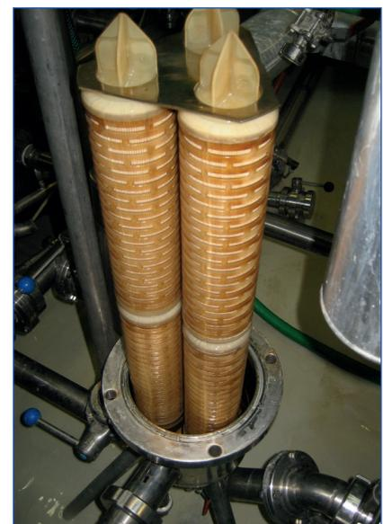
Abb. 2: Filterkerzen mit starken Schmutz- und Eisenbelägen auf der Anströmseite
