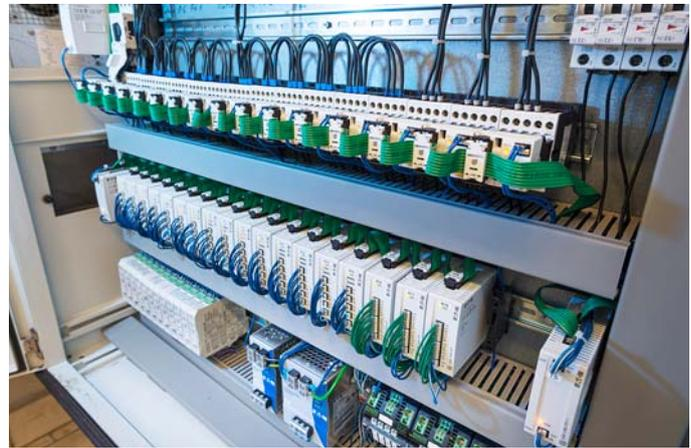
Über die Scheideanstalt verteilt kommen für verschiedenste Prozesse Touchpanel-Steuerungen (HMI/PLC) zum Einsatz, die mit rund 300 Komponenten über SmartWire-DT kommunizieren
